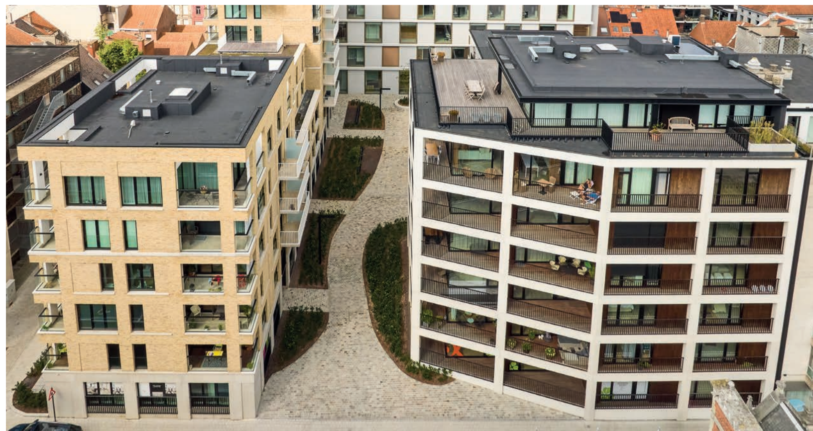
Projet de construction durable Bel-Ford dans le centre de Roulers.
